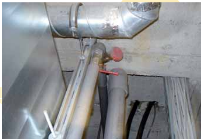
Rejtett zárt hurok a melegvíz-keringető rendszerben, amely helyet adott a Legionella fejlődésének – Forrás: OMFI
