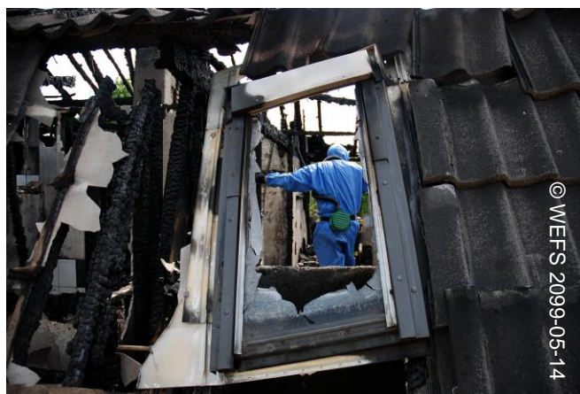
Azbeszteltávolítási munkálatok tüzesetet követően
